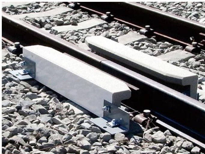
図 レール継目用防音材の設置状況
