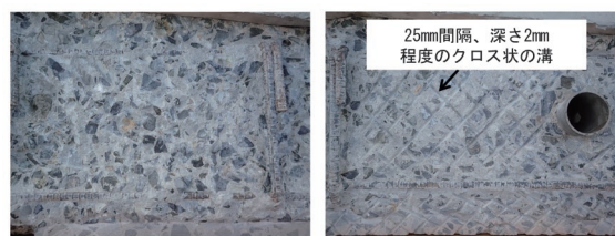
(a) 通常のはつり面 (b) 溝を設けたはつり面
