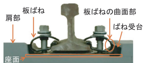
図1 直結4形レール締結装置
