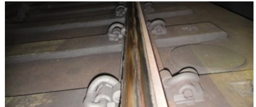
図1 外軌波状摩耗の発生事例 (コイルばね防振軌道の例)
