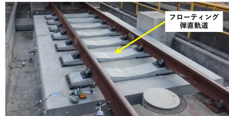
図7 試験敷設したフローティング弾直軌道
