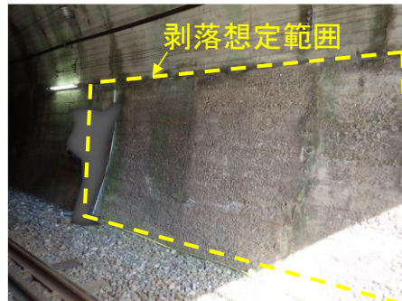
図6 施工前の状況
