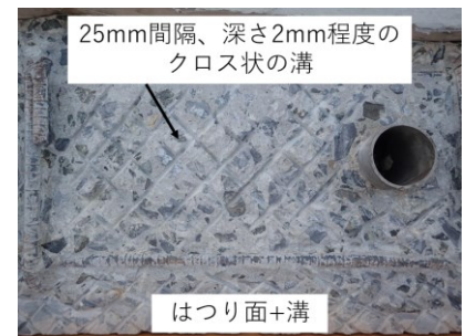
図 4 はつり面の状況 1)
