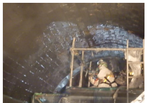
図4 樹脂吹付け状況
