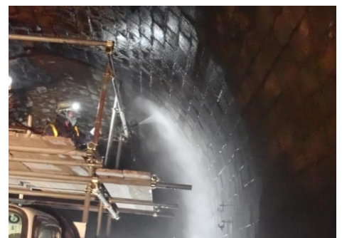
図3 ウォータージェットによる下地処理の状況
