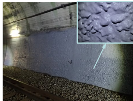
図7 施工後の状況
