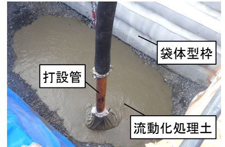
図1 流動化処理土打設状況
