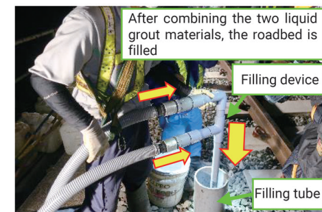
(d) Grout filling work
