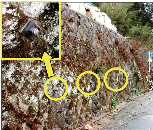
施工後の壁面の状態 石積み of 景観を残したまま 補強が可能です
