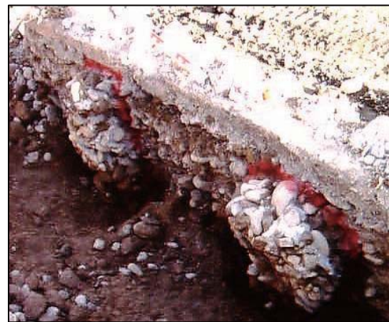
壁背後の固化体の状況 部分的な固化により裏グリ石層の 排水機能を維持します
