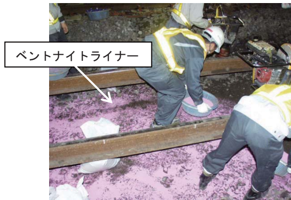
図4 BLITS工法試験施工
