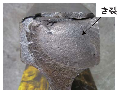
レール頭部の横裂
