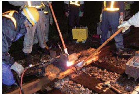
試験施工状況
