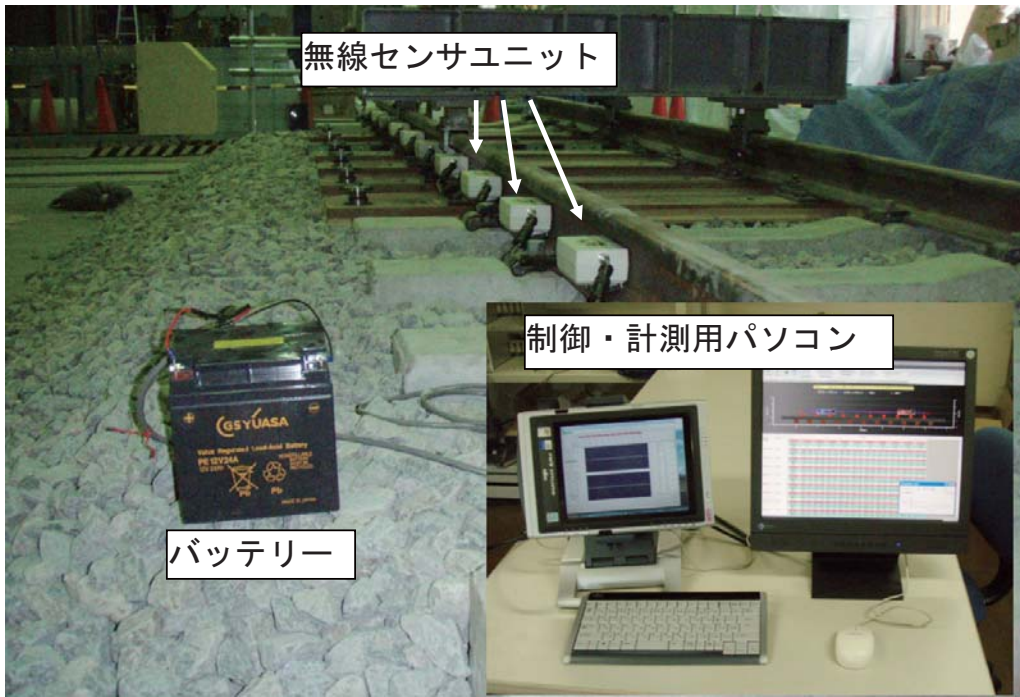
軌道変位常時監視システム
