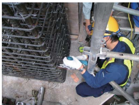
中央線への設置状況 設置時間: 1箇所当たり1時間以内
