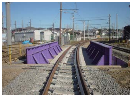
試験線に架設された鋼鉄道橋
