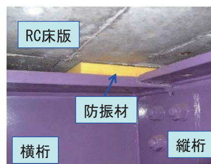
ラダーマクラギ下およびRC床版下の防振材の設置状況
