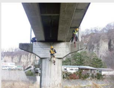
橋梁の健全度診断
