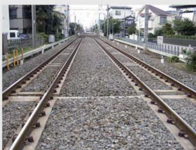
バラスト・ラダー軌道
