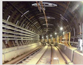
トンネル断面形状調査
