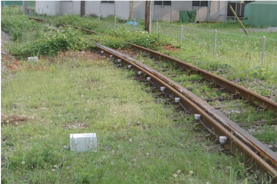
試験線における軌道変位常時監視の実証試験
