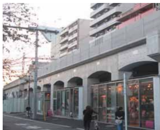
ラーメン高架橋のリニューアル
