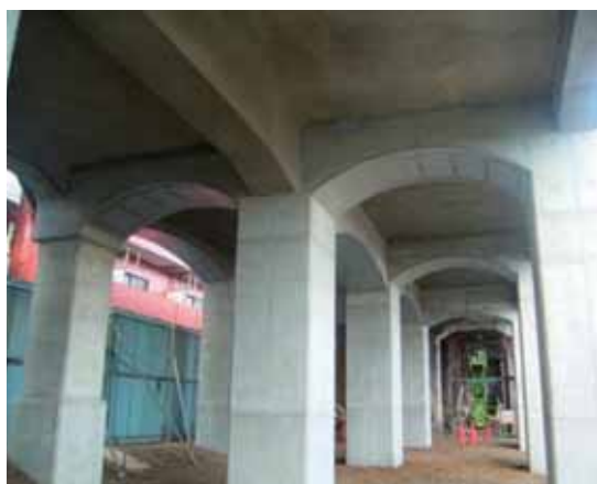
アーチサポート工法の施工例
