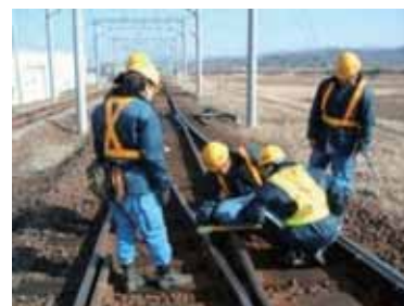
現地調査の状況
