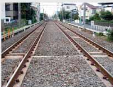
バラスト・ラダー軌道
