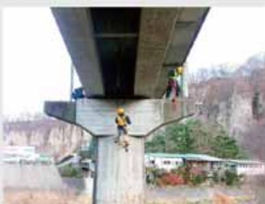
橋梁の健全度診断
