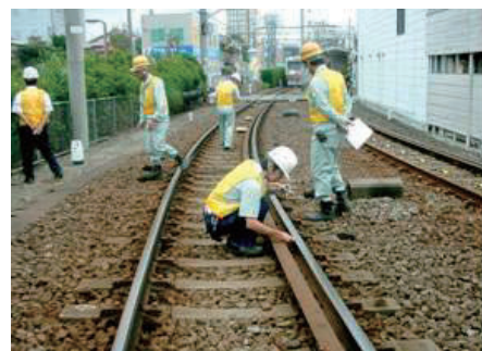
現地調査の状況
