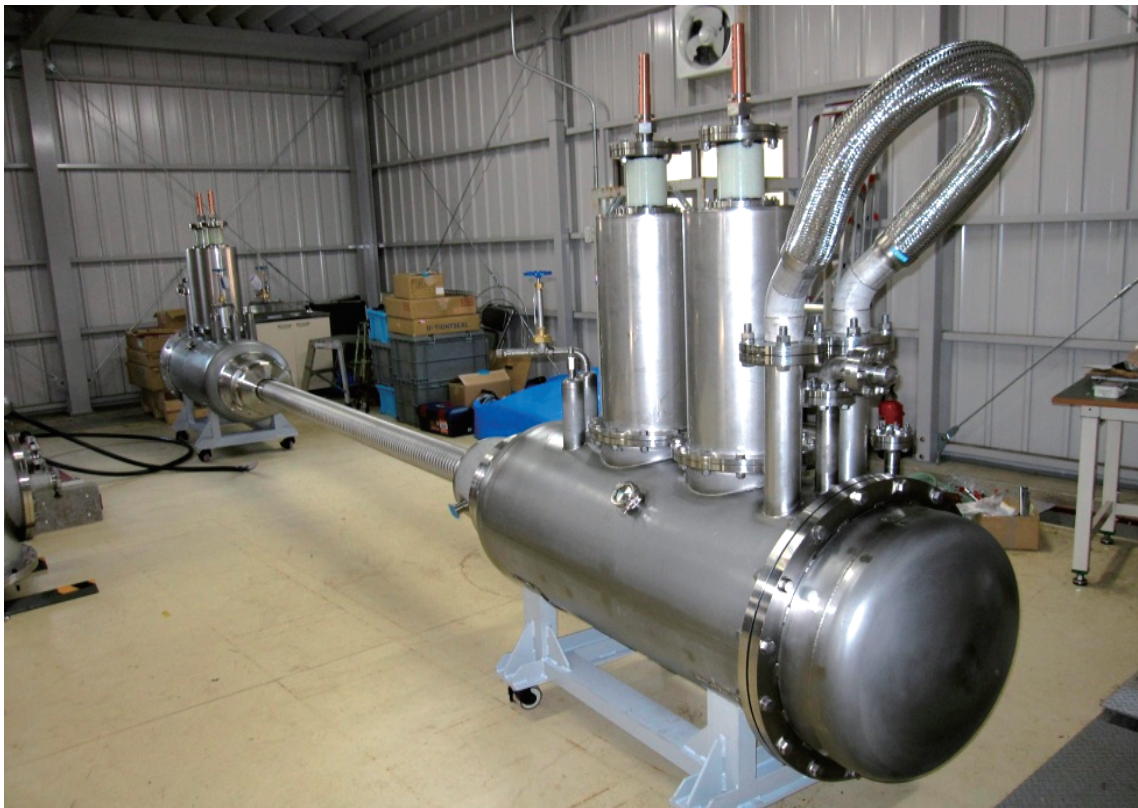
鉄道用超電導ケーブル試験装置
