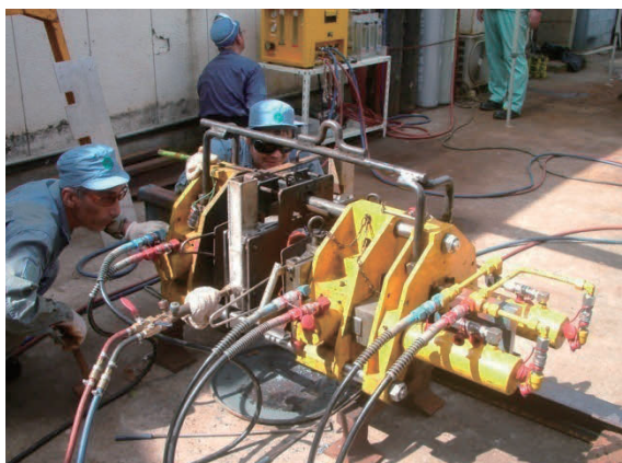
レールガス圧接作業状況
