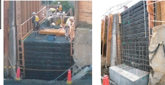
写真1 試験橋梁施工状況
