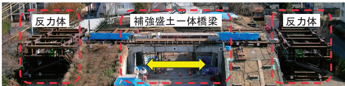
写真3 L2地震を想定した水平載荷試験
