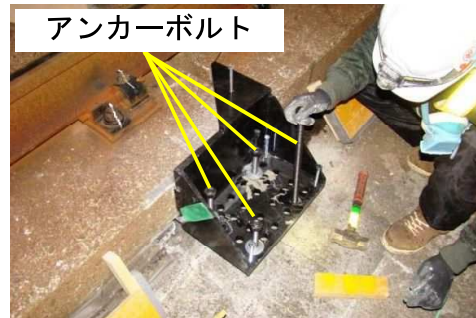
②アンカーボルトの施工
