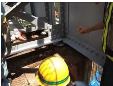
鋼橋の変状対策に関する現地調査
