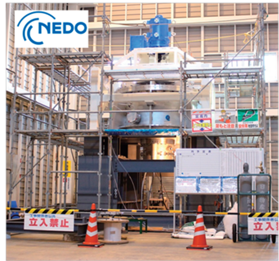
フライホイール蓄電装置外観
