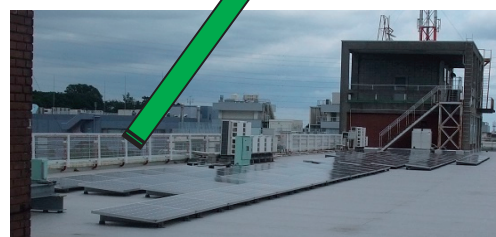
太陽光発電データを活用
