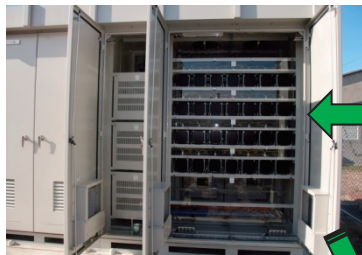
電力貯蔵媒体 リチウムイオンキャパシタ
