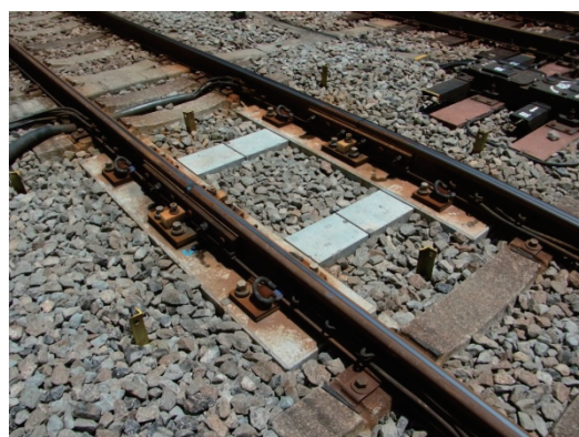
レール継目部 (3締結短尺タイプ)
