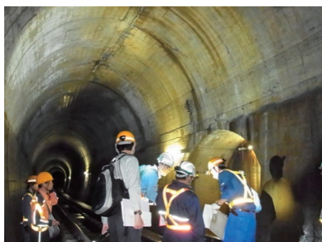
トンネル漏水対策に関する現地調査
