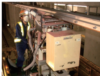
しゅう動面切削作業
