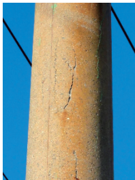
コンクリート柱の損傷の一例
