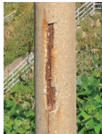
コンクリート柱の損傷の一例
