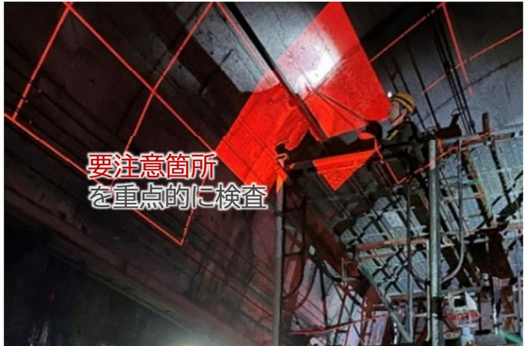
移動式のプロジェクションマッピング装置 要注意箇所が鮮明に表示されます
