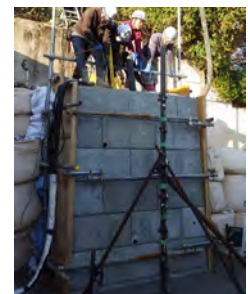
⑥コンクリート打設
