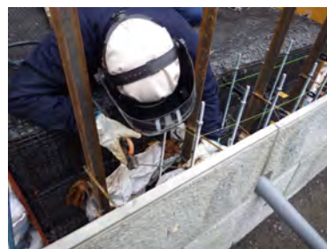
⑤沈下許容部材取付け
