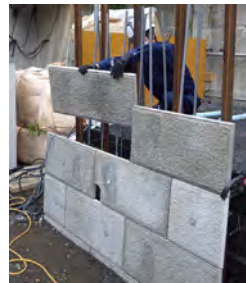
②埋設型枠設置
