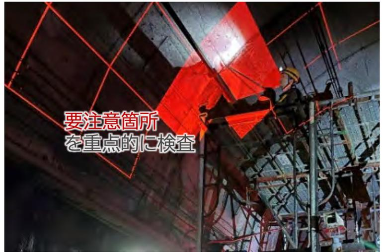
移動式のプロジェクションマッピング装置 要注意箇所が鮮明に表示されます
