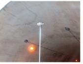
・親機のアンテナは高さ5mに設定 トンネルの入り口に配置
