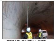
・無線機のアンテナは高さ4mに設定 計測は10mピッチにて実施
