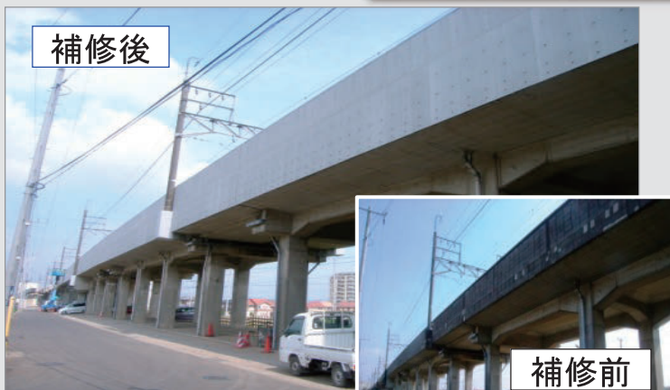
既設高欄の嵩上げと表面保護
