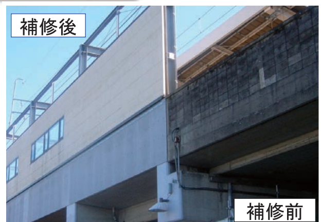
既設高欄の表面保護
