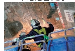
プライマー塗布状況
