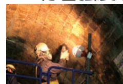
下地処理状況
