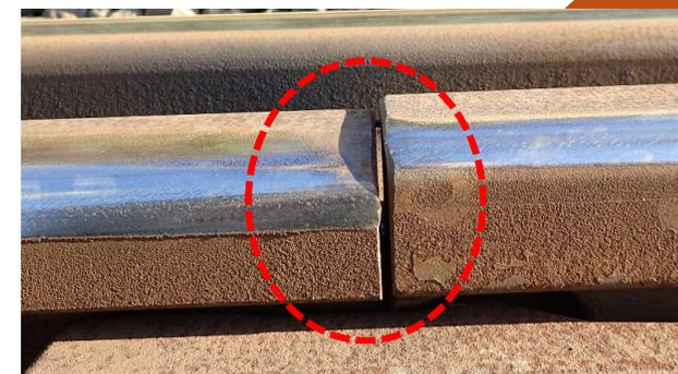
車両通過時の衝撃による応力変動が
