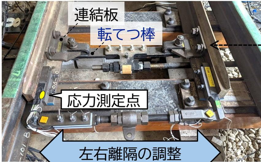
トングレールの先端密着の確保などを目的にフロントロッドの長さを調整
