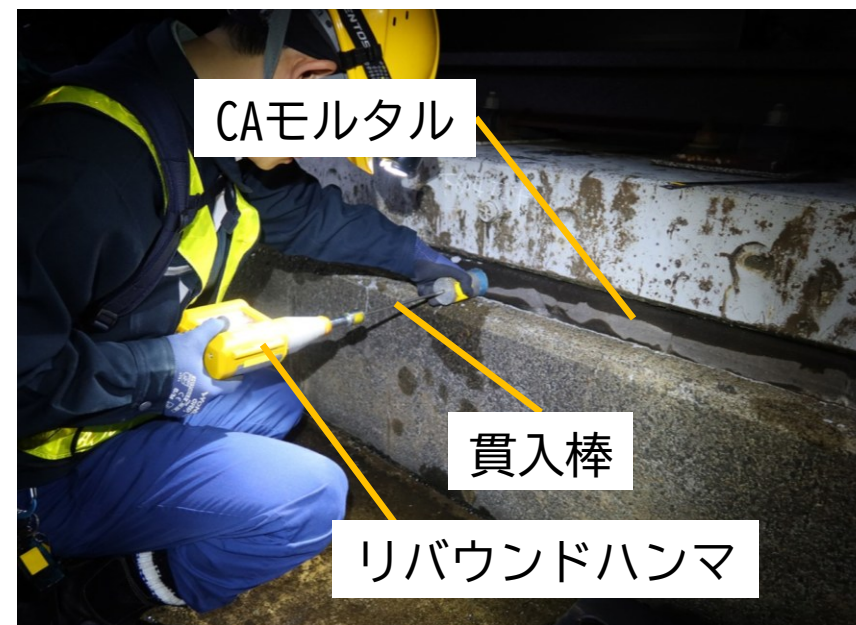
CAモルタルの衝撃貫入試験
