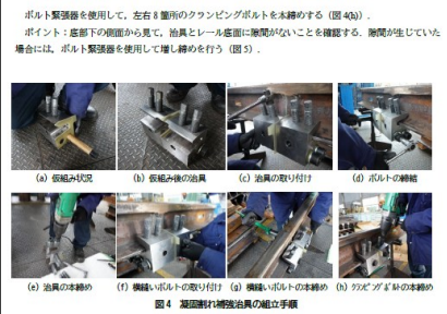
図4 凝固割れ補強治具の取付け手順
