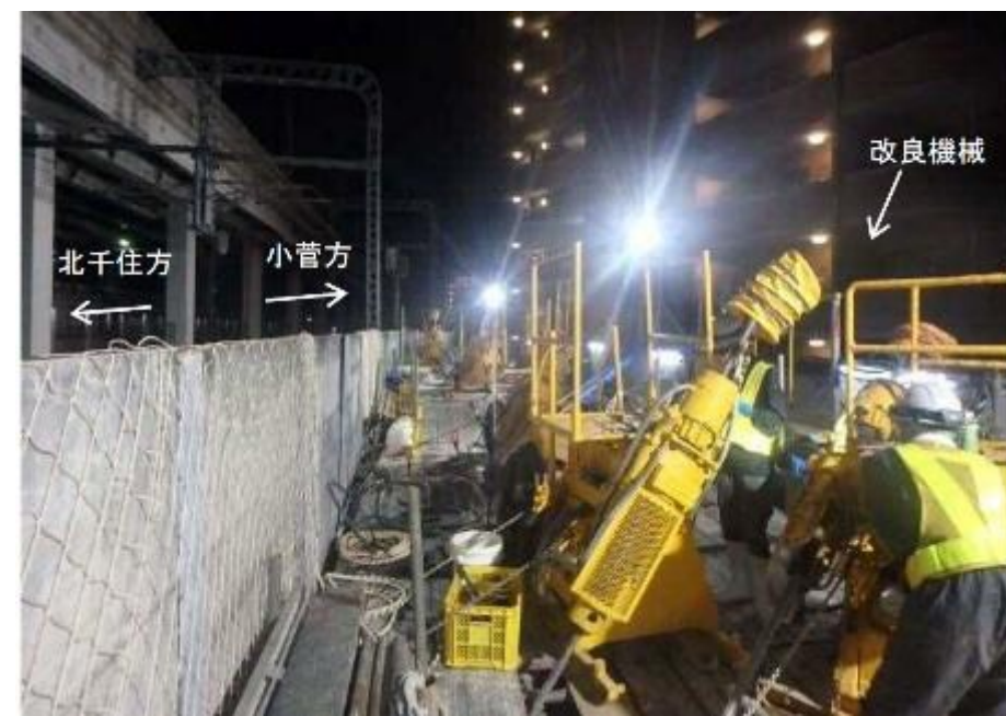
東武鉄道 北千住駅付近(2017) 盛土直下地盤の沈下対策
