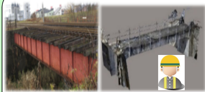
橋りょうの目視検査 支援システム
