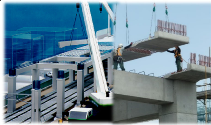
プレキャスト高架橋
