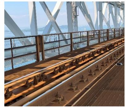
対象：瀬戸大橋 桁長13.1mの単純桁が連続する鋼直結軌道区間
