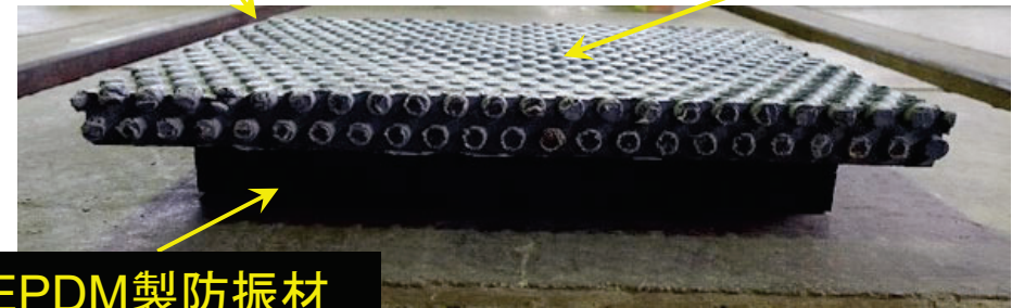
防振材の設置状況
