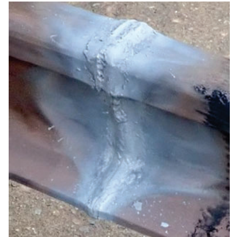
提案法によるガス圧接部
