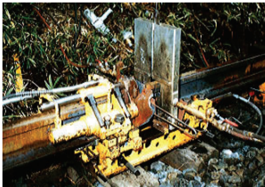
②圧接機のセット
