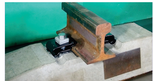
⑥工具撤去・締結完了
