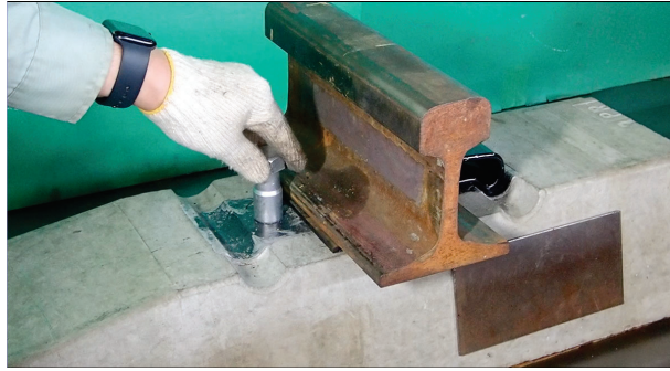
①ボルト設置
