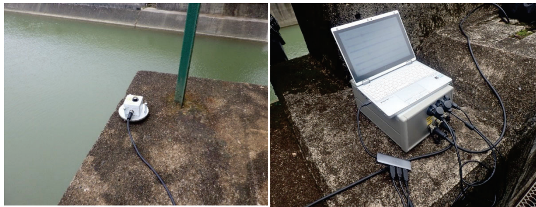
【可搬型システムの外観】
