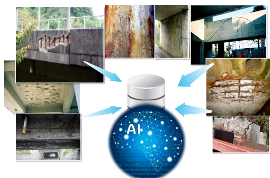
図13 変状データベースによる診断で性能予測
