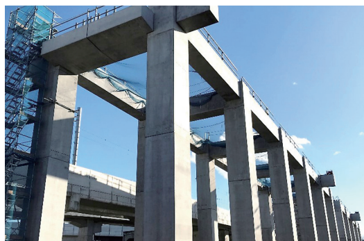
図2 北陸新幹線プレキャスト高架橋
