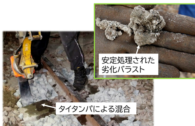
(b) つき固め作業による安定処理
