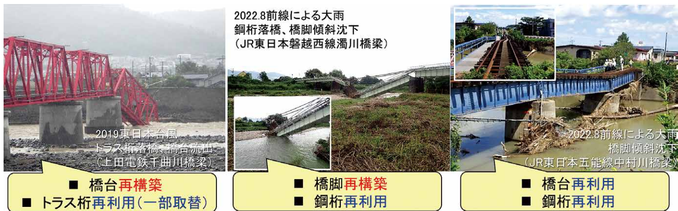
図 13 最近の被災鉄道インフラの復旧事例
