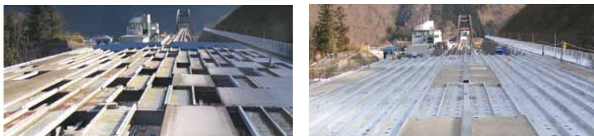
写真6 従来の緩衝工（左）と今回設置した緩衝工（右）
