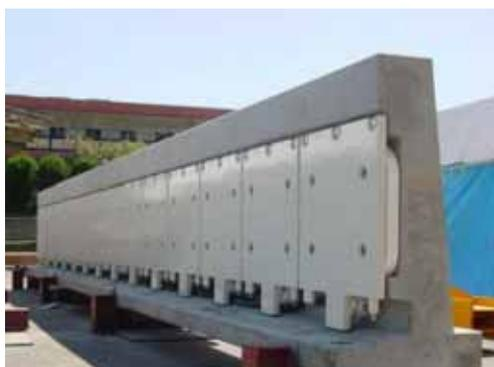
図3 自立可能な逆T型断面形状を採用したガイドウェイ
